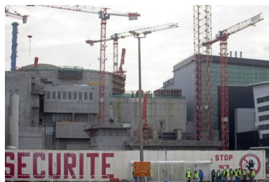
Le chantier de l'EPR à Flamanville, en janvier 2013. © Reuters.
