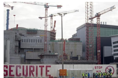
Chantier de l'EPR à Flamanville © Reuters
