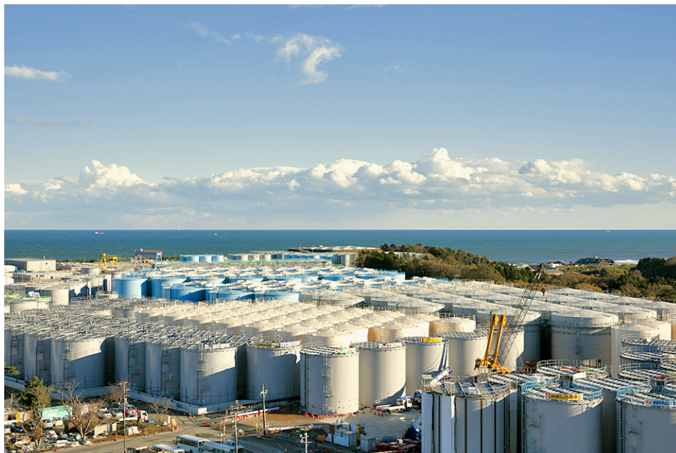
Cuves de stockage des eaux contaminées sur le site de la centrale de Fukushima Daiichi, d'une capacité de 1,37 millions de tonnes.
